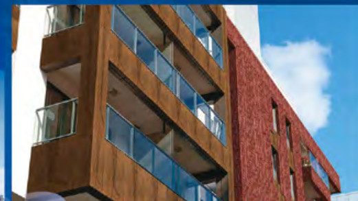
3 Отделка многоэтажных жилых домов
